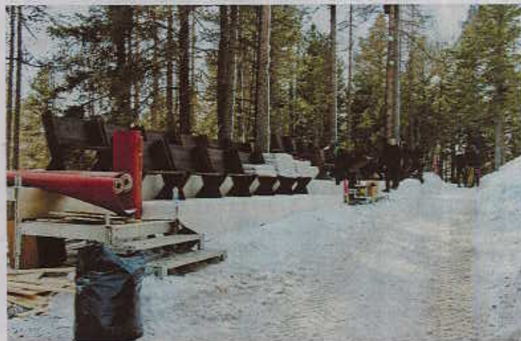
Bereits seit Tagen wird die Infrastruktur für die Modenschau im Wald erstellt. Foto: Julia Biffi
